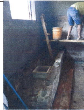
Foto 4: Sustitución de piso de torta de concreto en cocina
