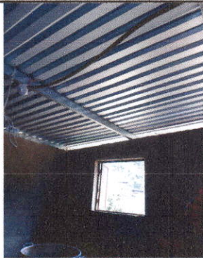
Foto 5: Sustitución de lámina, por lámina troquelada en cocina
